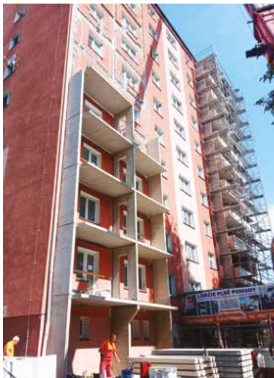
Úspešná realizácia nových lodžii na ul. Športovcov 1175 firmou EKONOMSERVIS, s.r.o.
